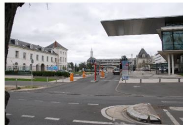
L'entrée principale du site
