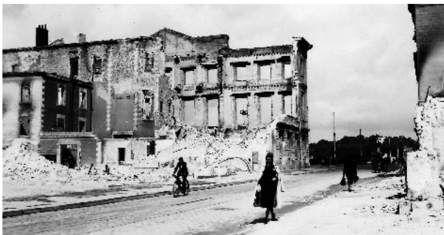
Fig. 10 : La Bibliothèque incendiée, vue de la rue Nationale, à l'automne 1940 (Coll. SAT).
