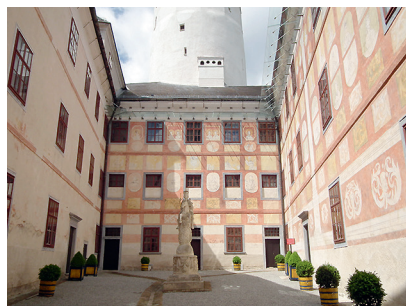
Fig. 6 : Cour du château de Fraknó (cliché Couderc).
