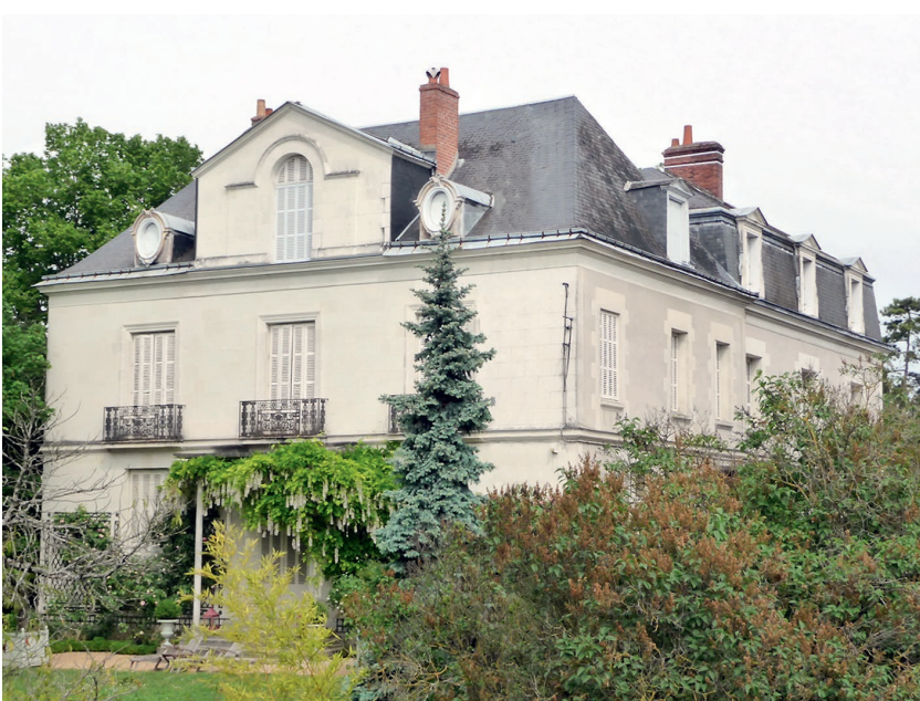
Fig. 1 : la propriété de La Fontaine, façade sud; en haut vers 1900, en bas, vue actuelle.
