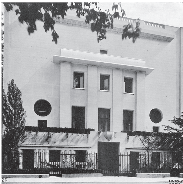
Fig. 3 : Hôtel particulier de François Ducharme à Paris, Pierre Patout architecte, 1925. Source : [Anonyme] [vers 1935]. Pierre Patout, architecte, urbaniste, décorateur. EDARI, Strasbourg.
